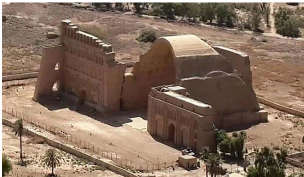
شکل ۲۰: عکس هوایی پیش از ریزش کامل دیوار سمت راست ۲
