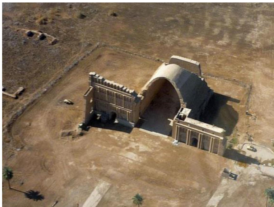
شکل ۱۹: عکس هوایی پیش از ریزش کامل دیوار سمت راست ۱
